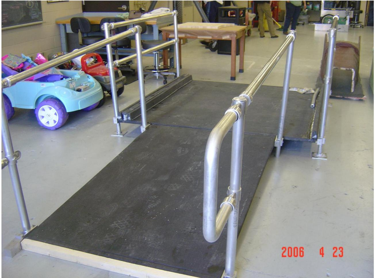
Fig. 13.5. Composite Modular Ramp System.
